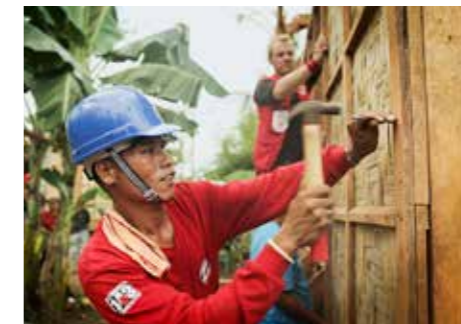
Den Aufbau der neuen Unterkünfte übernehmen lokale Bauteams.
