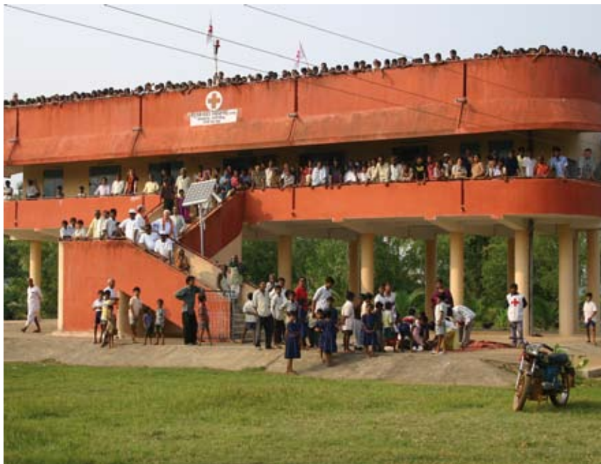
Hochwasserschutzbau in Indien.
