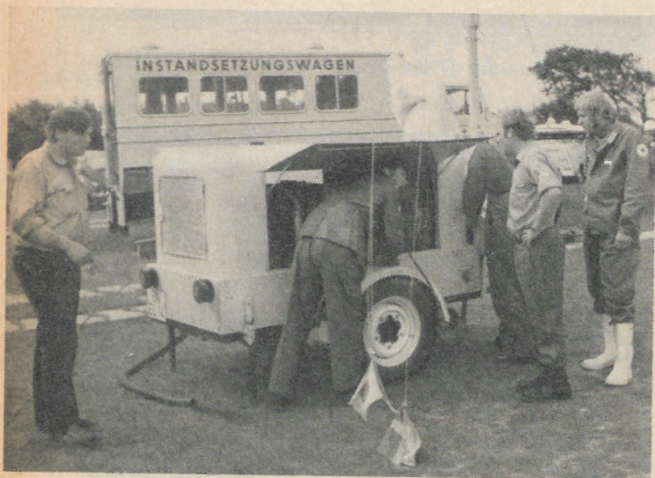
Ausbildung am Notstromaggregat mit 15 kVA. Der reichhaltige Instandsetzungswagen der Hilfszugstaffel im Hintergrund.
