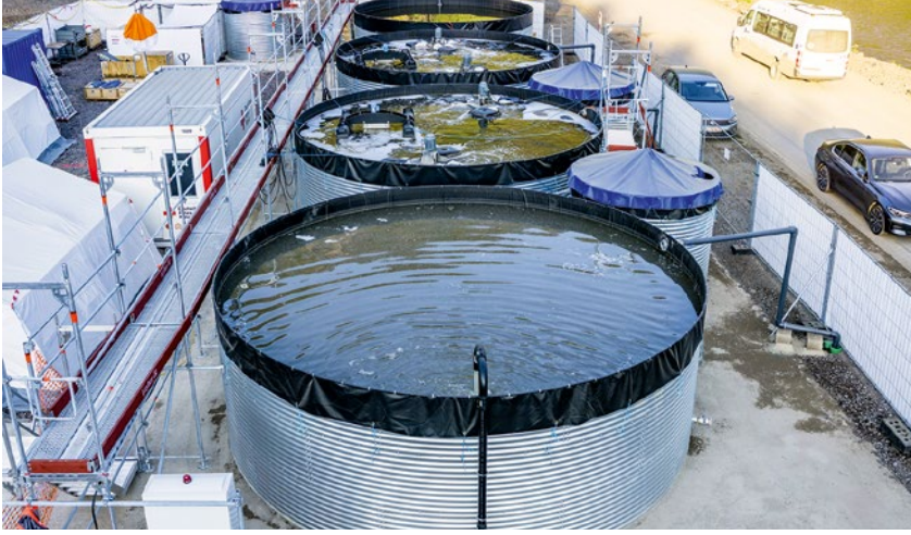
Erstmals in Deutschland eingesetzt: Temporäre Kläranlage des DRK bei Mayschoß.
