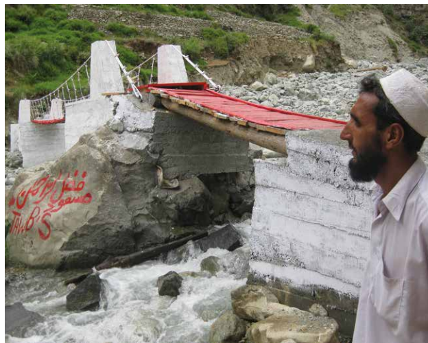
Stabile Brückenkonstruktionen im Nordwesten Pakistans sichern auch in einer Springflut die Erreichbarkeit der Dörfer.
