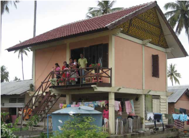
Wiederaufbau von erdbeben- und flutresistenten Häusern in Indonesien nach dem Tsunami 2004 durch das DRK. Foto: DRK 2008
