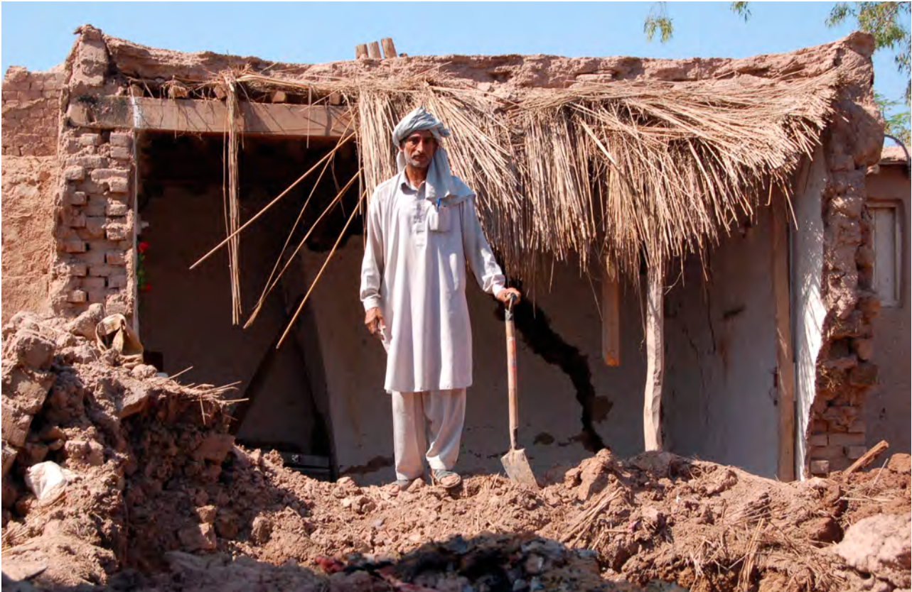
Schäden infolge der Überschwemmungen in Pakistan 2010. Photo: DRK 2010
