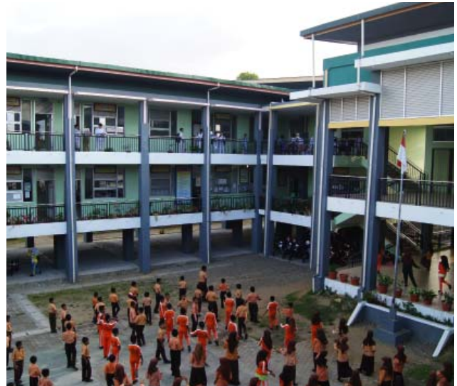
Indonesien: Wiederaufbau von erdbeben- und flutresistenten Schulen nach dem Tsunami 2004 durch das DRK.
