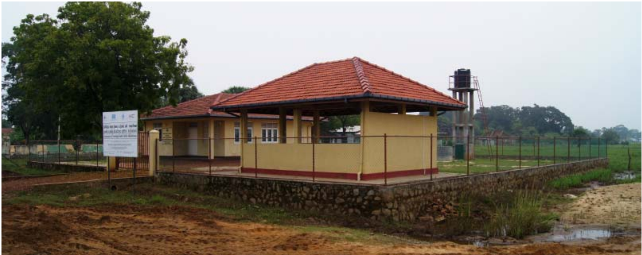
Sri Lanka: Aufbau einer Gesundheitsstation in einer besonders überschwemmungsgefährdeten Region. Zeitgleich mit dem Aufbau einer solchen Gesundheitsinfrastruktur führt das DRK in Kooperation mit der Nationalen Gesellschaft umfangreiche Maßnahmen der Gesundheitsaufklärung durch. Photo 16: DRK 2013
