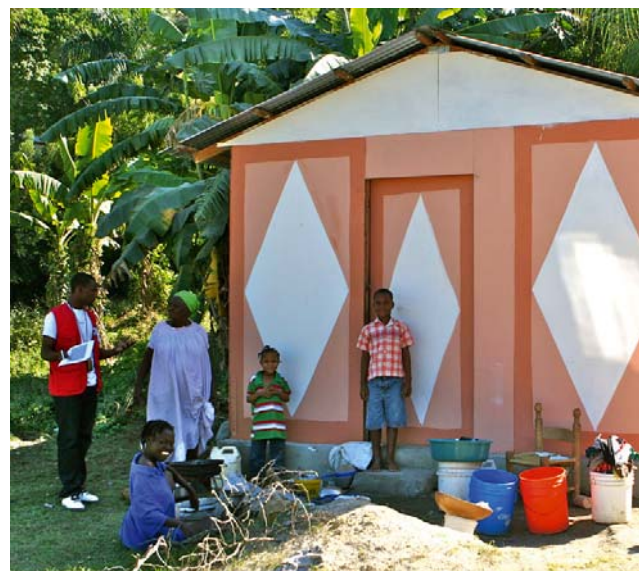
Haiti: Erdbeben- und sturmresistente Übergangshäuser („Shelter“) des DRK nach dem Erdbeben 2010. Die Menschen konnten die Außenfarbe ihrer Häuser selbst wählen.
